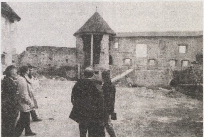
ZAČETEK - Lani obnovljena in utrjena južna stena.
