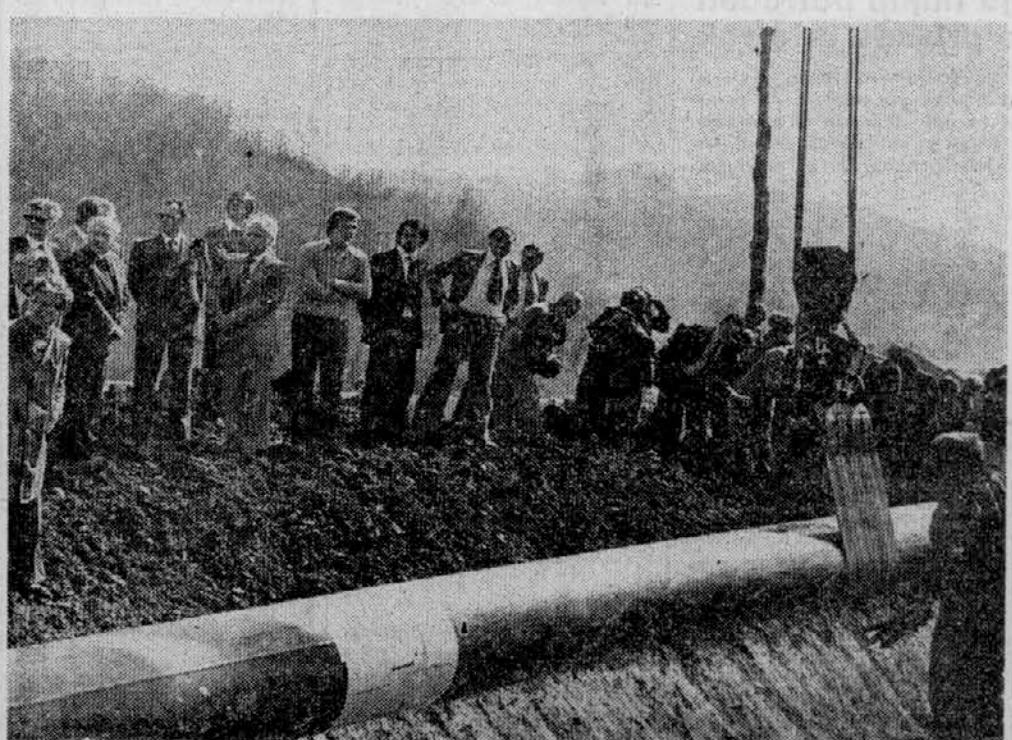
SLOVESNOST V JAKOBSKEM DOLU — Gradbišče slovenskega plinovoda so včeraj tudi uradno odprli, sicer pa dela že lepo tečejo. Foto: Bogo Čerin
