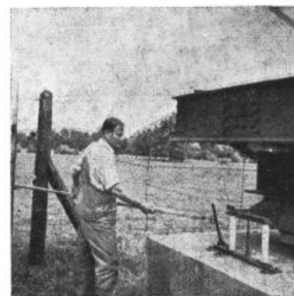
Ozemljevanje antenskega stolpa pred nevihto.
