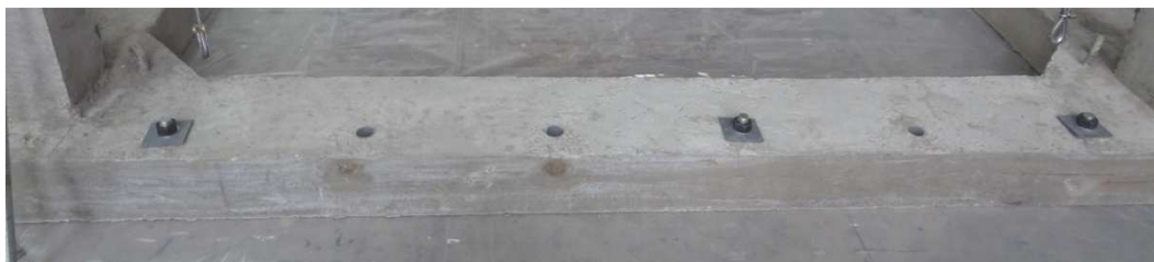
Slika 6.10: Temelji konstrukcije med vijačenjem v platformo Figure 6.10: RC foundation being bolted onto the platform
