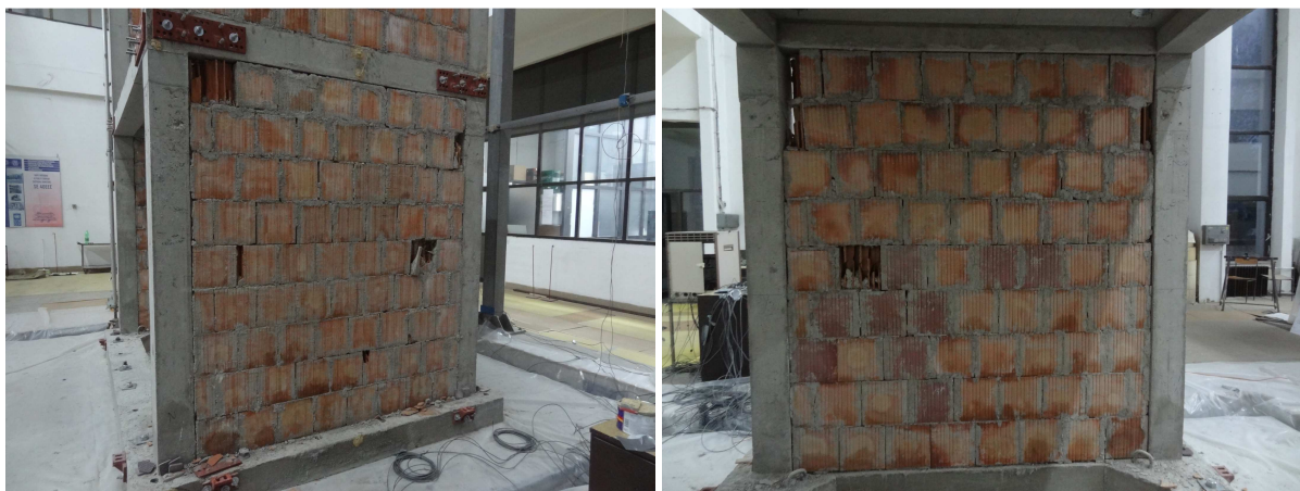
Slika 6.25: Poškodbe opečnega polnila po zaključku testov neutrene konstrukcije
