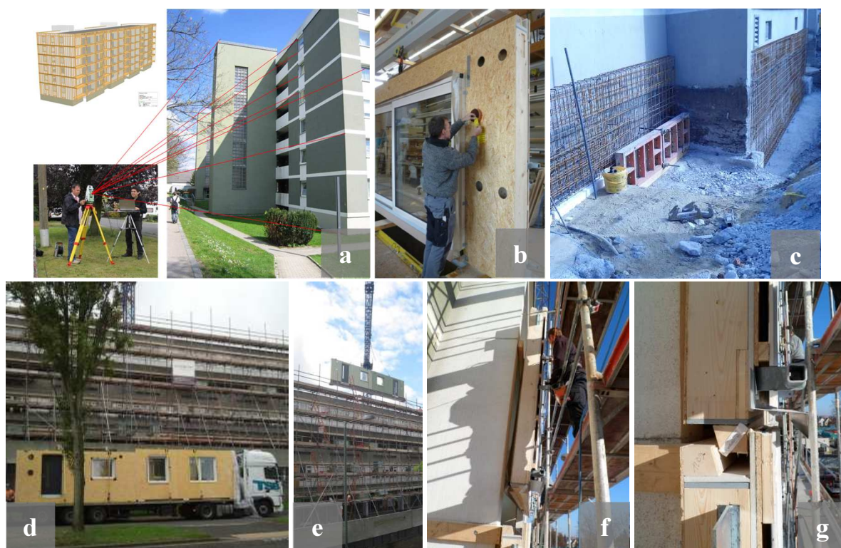
Slika 1.4: Obstoječa rešitev za toplotno izoliranje objektov z uporabo prefabriciranih lesenih okvirnih panelov v kombinaciji s celotno fasado; (a) meritev in izdelava 3D računalniškega modela, (b) izdelava lesenih panelnih sten v obratu, (c) po potrebi sanacija temeljev oz. izdelava novih, (d) dostava na teren, (e) montaža, (f) uporaba samostoječega odra za izvedbo ovoja (vidna tudi izravnalna linija v nivoju medetaže), (g) detajli preklopa stenskih panelov po višini (vir: Gump & Maier, GmbH)
