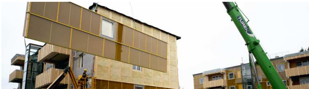
Slika 1.3: Obstoječa rešitev za toplotno izoliranje objektov z uporabo prefabriciranih lesenih okvirnih panelov v kombinaciji s celotno fasado (vir: Gap Solutions, GmbH)
