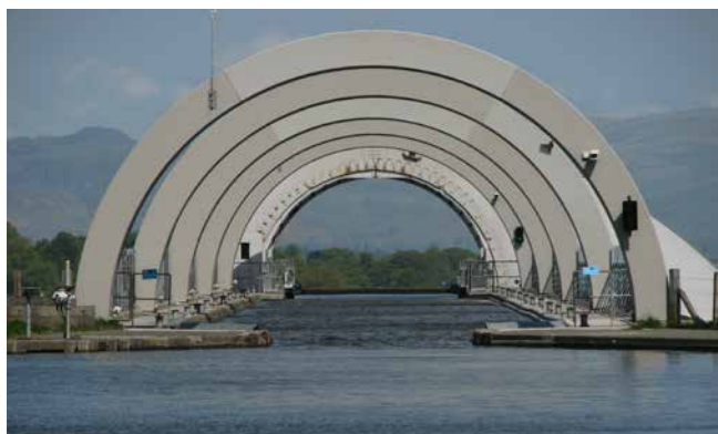
» Kanal Forth-Clyde se začne z akvaduktom.
