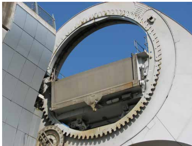
» Gondola je vpeta v krožno tračnico.
