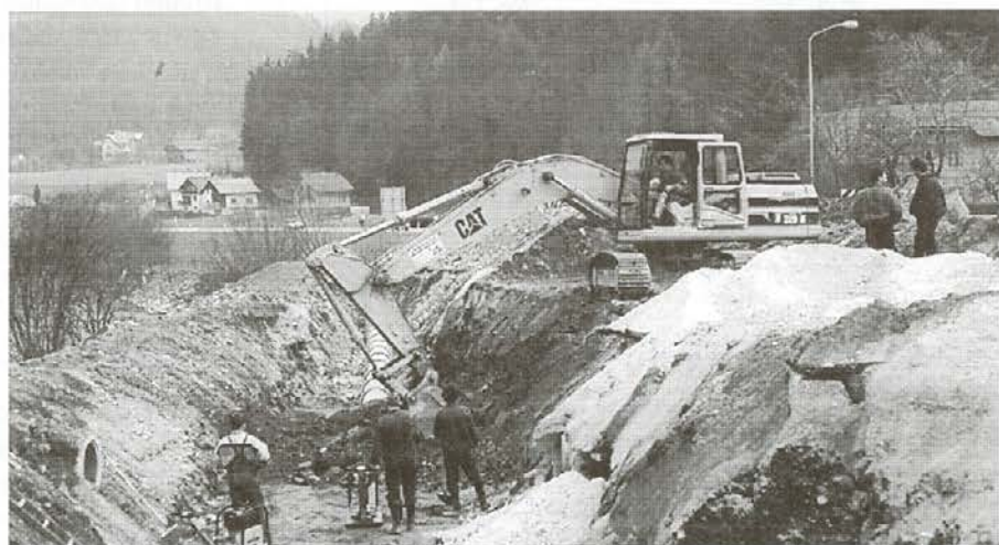
Kanalizacijska dela v Mestni občini Slovenj Gradec
