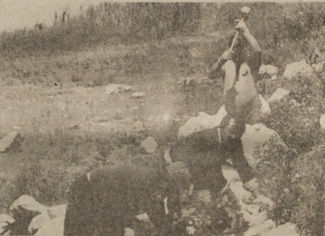
— Resda ena lastovka še ne prinese pomladi, toda kar je res, je res: delavci vodnogospodarskega podjetja tozđ Mura so te dni začeli z urejanjem obrežja jezera v Kraščih
