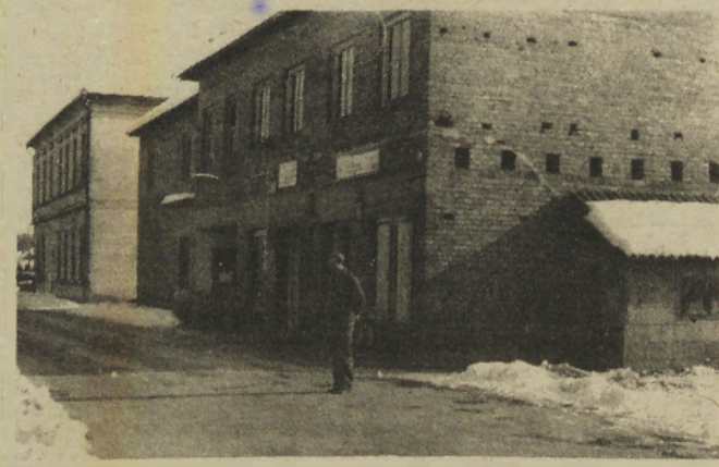
Zadružni dom in zgradba osnovne šole v Lipi, ki čakata na adaptacijo.
