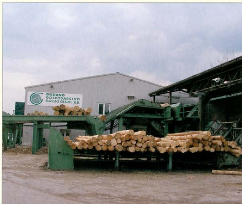
Postrojenje profilne linije in žagalnice
