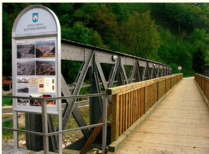
Obnovljen železniški most
