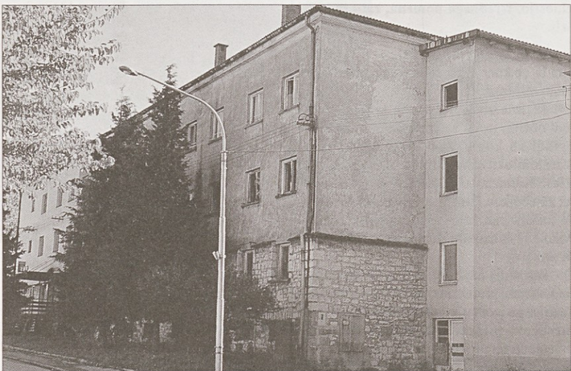
Stara Soča' je že nekaj časa samo v spotiko svoji okolici, že čez nekaj let pa bo postala sodoben stanovanjski objekt s petnajstimi stanovanji. Slika: P. Nikolič
