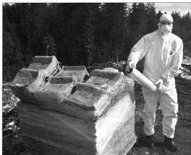
Delavci Komunale so pri ravnanju z azbestnimi odpadnimi materiali dolžni uporabljati vso predpisano zaščitno opremo (foto: EMS)
