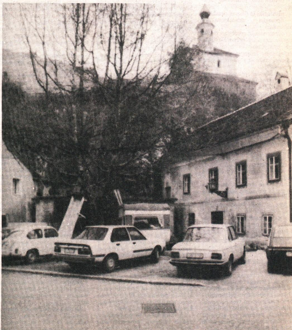
Kdaj bo Trg svobode ponovno osvobojen gradbene navlake iz Malega gradu in pločevine?! Kdaj bo resnično zaživel kot trg? (Foto: R. G.)
