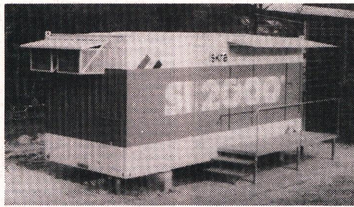
Kontejner - telefonska centrala
