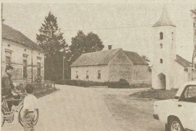
Vaške poti v Strehovcih so odete z asfaltom. Za asfaltiranje približno 4 kilometrov vaških cest so porabili okoli 200 milijonov dinarjev.
