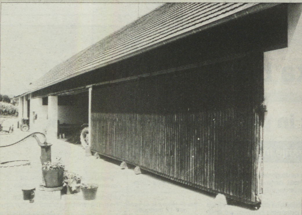
Urejeni gospodarski objekti Kupljenove kmetije, v katerih je dovolj prostora za stroje in mehanizacijo.
