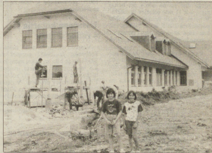
Petošolki Sanja in Zinka sta bili tako radovedni, kakšna bo nova šola pri Mali Nedelji, da sta si jo šli ogledat kar med gradnjo. (Fotografija: J. G.)
