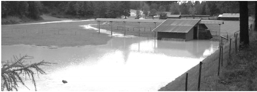
Slika / Figure 35 Močno deževje, 2003. Heavy rain, 2003.
