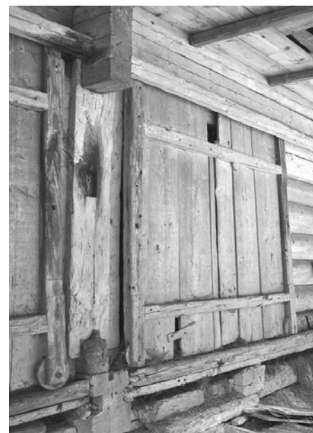
Slika / Figure 10 Drnsna vrata pri skednju na Kozjaku 19. stoletje. Tuhinj, 2004. Barn Sliding-door, Kozjak, 19 th Century. Tuhinj, 2004.
