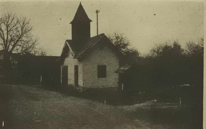
Ob starem gasilskem domu bodo že v letošnjem letu zgradili novega, v katerem bodo tudi prostori za civilno zaščito ter splošni ljudski odpor in družbeno samozasčito. Gradnja doma bo veljala približno milijon dinarjev, ki ga bodo v glavnem zagotovili sami.
