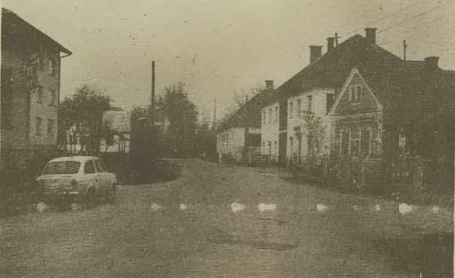
V Kobilju so med prvimi v lendavski občini sprejeli krajevni samoprispevek, ki je omogočal razvoj. S pomočjo njega so asfaltirali ulice, napeljali vodovod, ulično razsvetljavo, pripravljajo pa se na gradnjo transformatorjev. V tem srednjeročnem obdobju bodo v vasi uredili tudi telefonijo.
