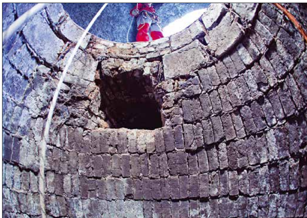
Pod vsipno ploščadjo v žrelu je vidna odprtina, skozi katero so zajemali vroče plavžne pline za ogrevanje zraka, ki so ga s pomočjo mehov vpihali skozi šobe v spodnji del plavža in s tem povečali izkoristek samega taljenja. Foto: Andrej Bogataj
