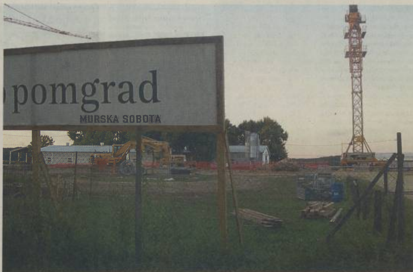
Gradnja bioplinarne v Motvarjevcih
