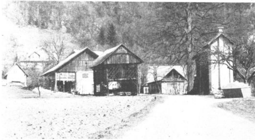
Največ dela v tem letu čaka krajanje Bevč pri izgradnji telefonskega omrežja
