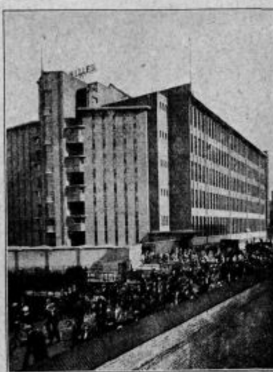
PHILIPSOVA UPRAVNA ZGRADBA V EINDHOVENU Z 1200 URADNIKI
