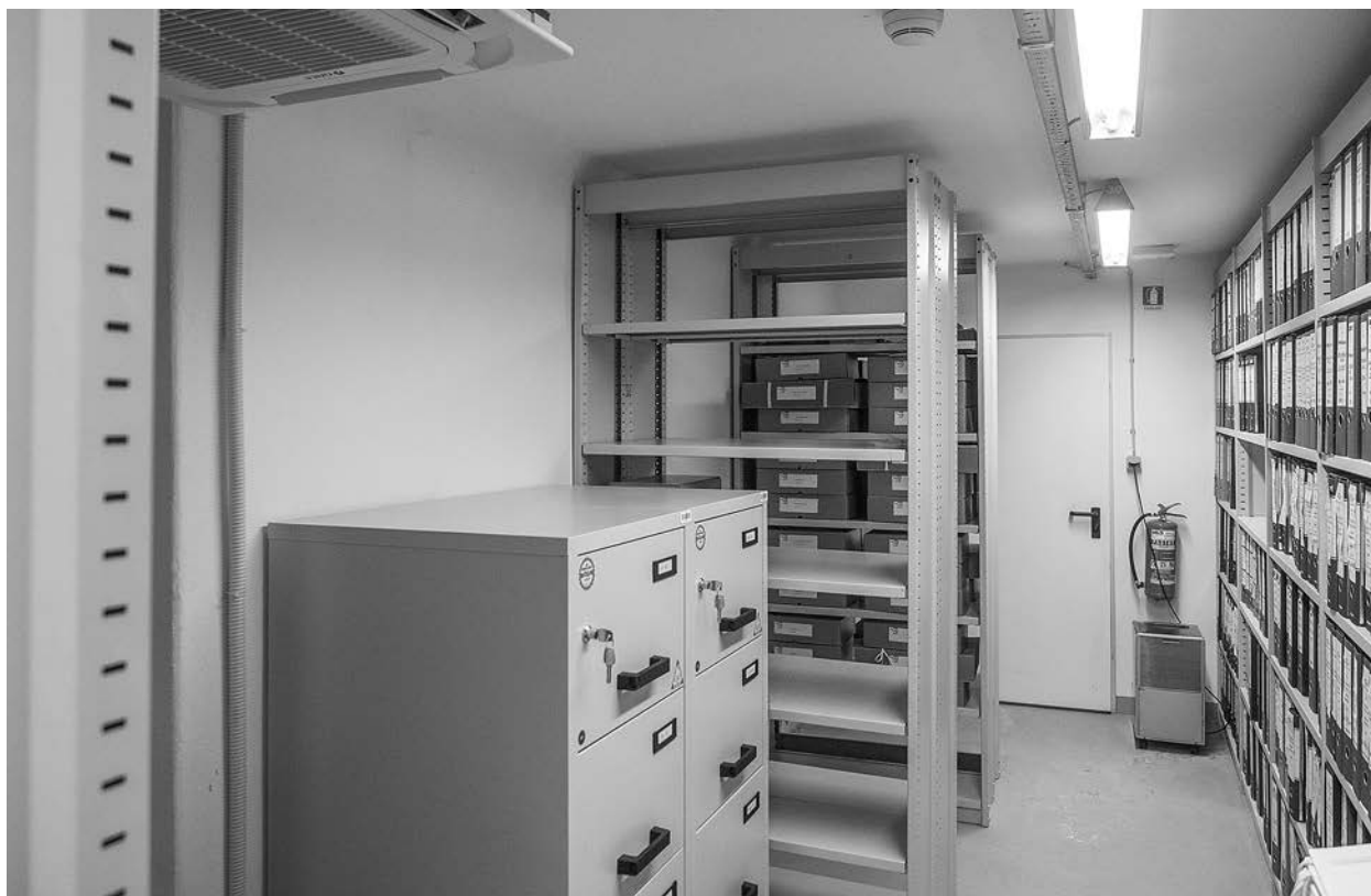
Opremljenost prostora stalne zbirke NUK v kleti Plečnikove stavbe: kovinska oprema, gasilni aparat, razvlažilnik, klimatska naprava in javljalnik požara (Foto: Maj Blatnik 2023)
