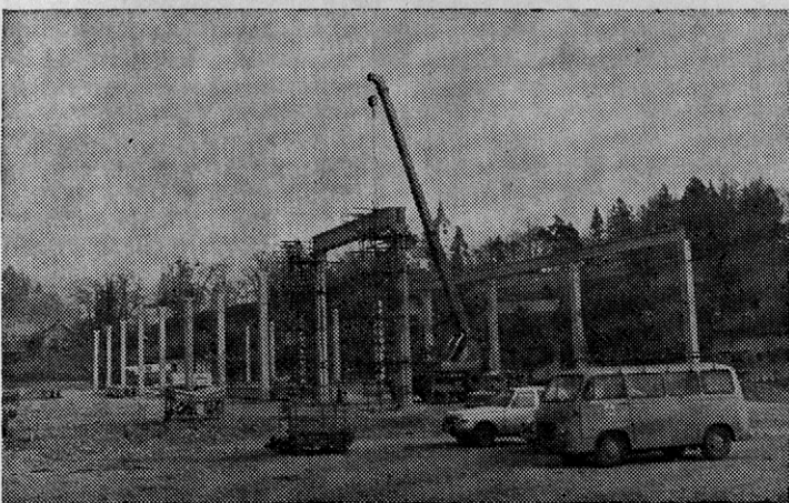
Za montažo se uporablja specialno dvigalo
