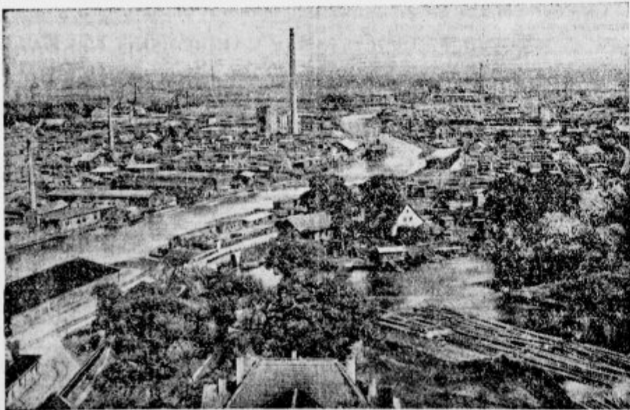
Pogled na industrijske naprave v Klajpedé
