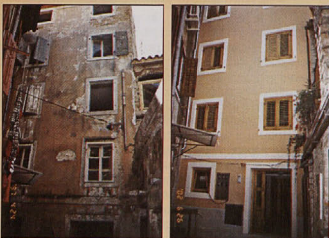
Stanovanjski objekt - Smrekarjeva 55, pred in po obnovi.
