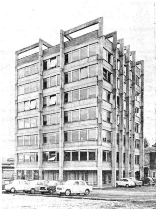
Upravna stavba LTH na Trati
