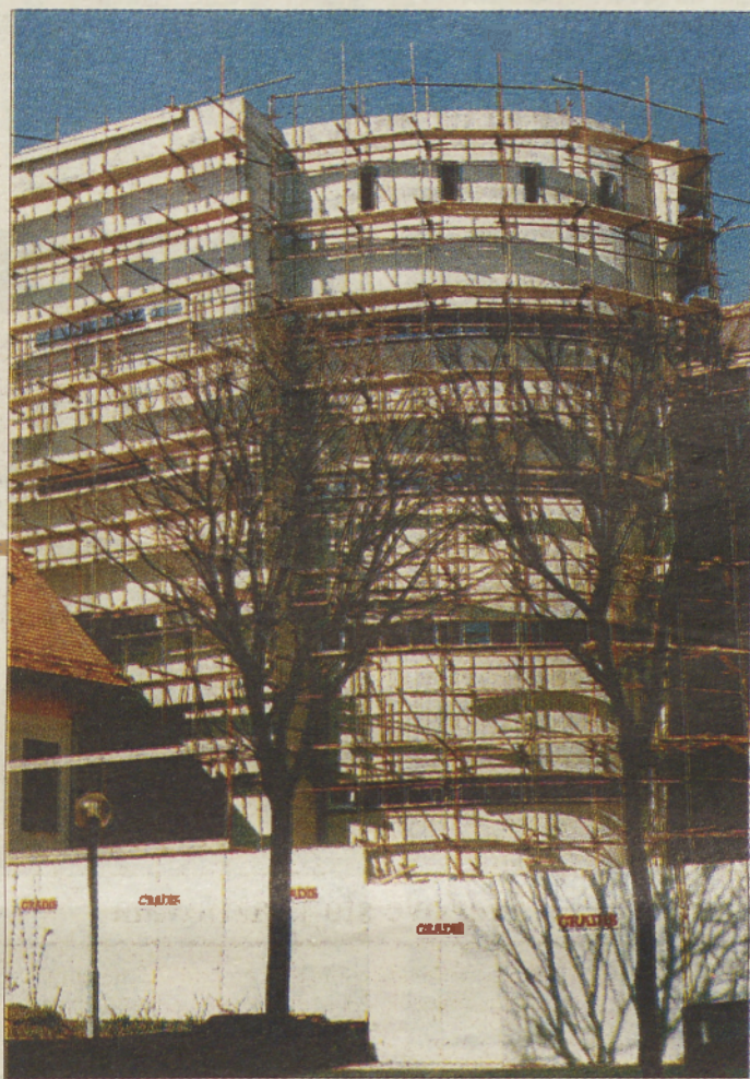
To pa je pogled na Andreanum z dvorišča stare škofijske stavbe v Slomškovi ulici. Izstopa objekt v obliki elipse (fotoobjektiv je uspel ujeti le polovico stavbe). V njem bodo predvsem prostori Škofijske knjižnice, ki ima 60.000 enot. - Fotografija: S. S.
