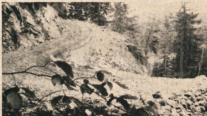
GRADNJA CESTE NA PRAPROTNO
