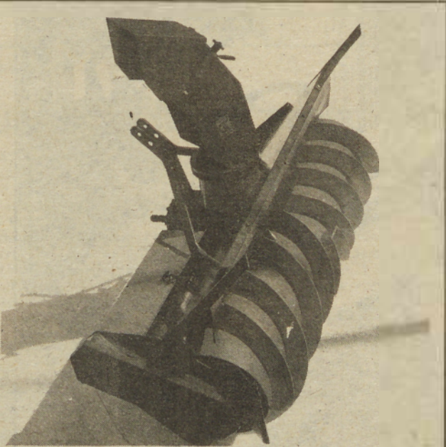
SNEŽNO PUHALO CSP 2 CIMOS moč: 50—60 kW delovna širina: 2000 mm delovna globina: 600—800 mm teža: 440 kg delovna hitrost: do 2 km/h
