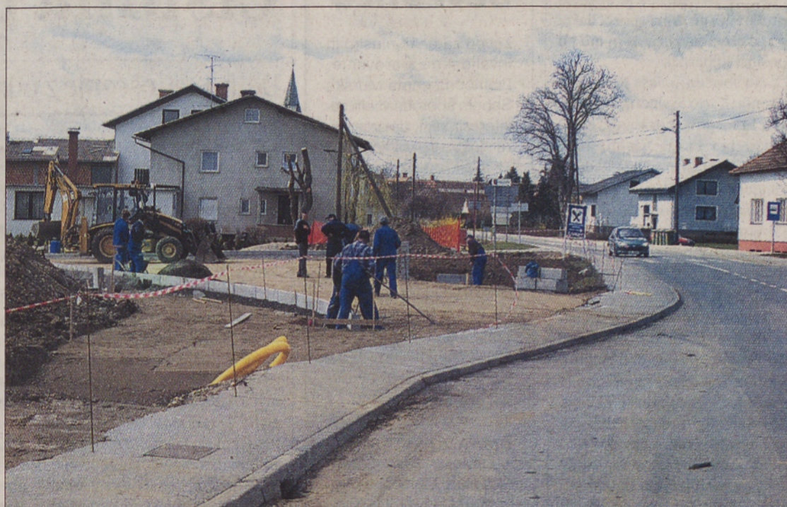
Krožišče v Moravskih Toplicah je zaradi Term 3000 prav gotovo potrebno, vendar domačini upajo, da bo sedaj vendarle na vrsti tudi krožišče pri Čardi, ki pa je na ozemlju Mestne občine M. Sobota in za obnovo predvideno šele leta 2004.
