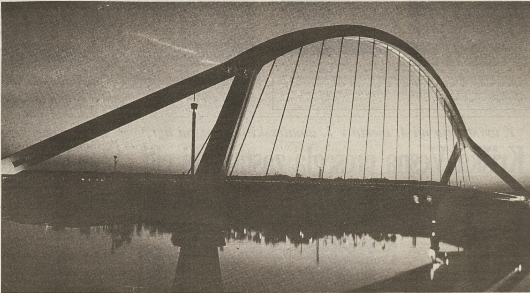
V Seville so tik pred odprtjem EXPO izročili prometu kar 7 novih mostov čez Guadalquivir. Tudi Puente de la Barqueta, na sliki, je odraz sodobnega arhitektonskega gledanja na dogajanje
