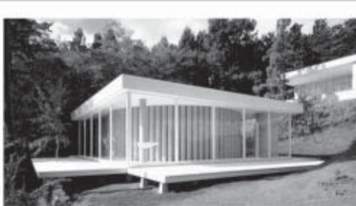
□ Slika 17. Hiša z nosilnimi elementi iz papirnatih tulcev (Shigeru, 1997)
