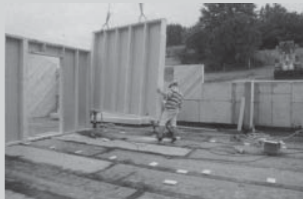
□ Slika 5. Okvirno konstrukcijo sestavljajo leseni okviri iz stebrov in prečk. (Grützmacher, 1998)
