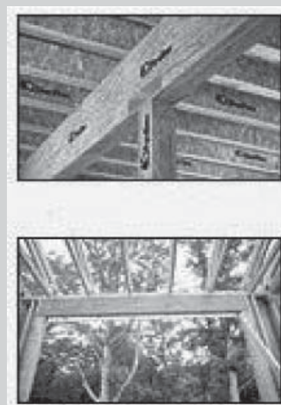
□ Slika 2. Kompozitni les se vedno bolj pogosto uporablja namesto klasičnega žaganega lesa in lepljenih nosilcev. Elementi so dimenzijsko stabilni, se ne krivijo in ne pokajo. ( http://www.trusjoist.com )
