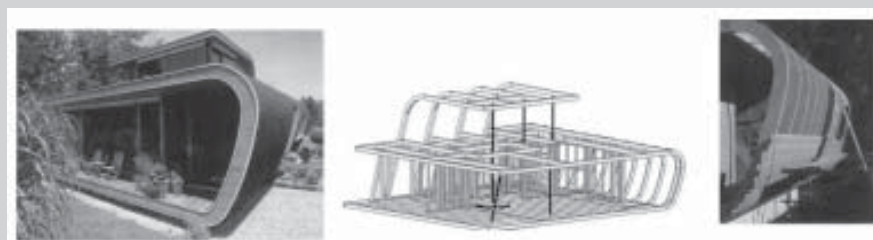
□ Slika 3. Alternativna arhitekturna lupina enodružinske hiše z lesnim ogrodjem. Lepljeni nosilci so obojestransko obloženi z lesenimi deskami, med katerimi je toplotna izolacija. Zunanja troslojna obloga, ki je za vodo neprepustna zaščita lesene konstrukcije, pa je iz bitumna. (Bügelmayer 2004)
