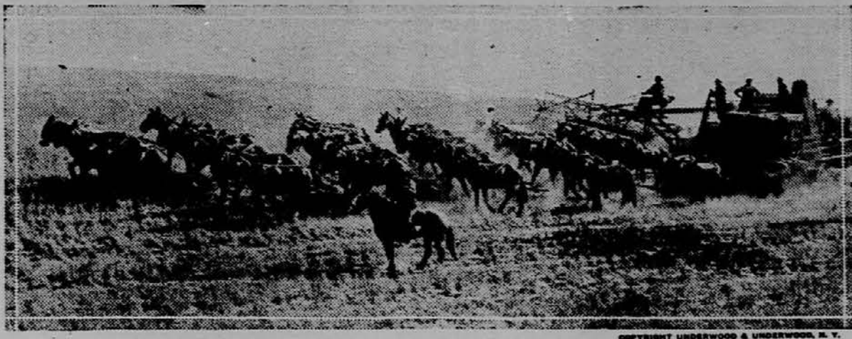
Slika nam kaže prizor z velikanskega polja v severnem delu Californije. V stroj, ki obenem žanje in mlati, je vpreženih 34 mul.
