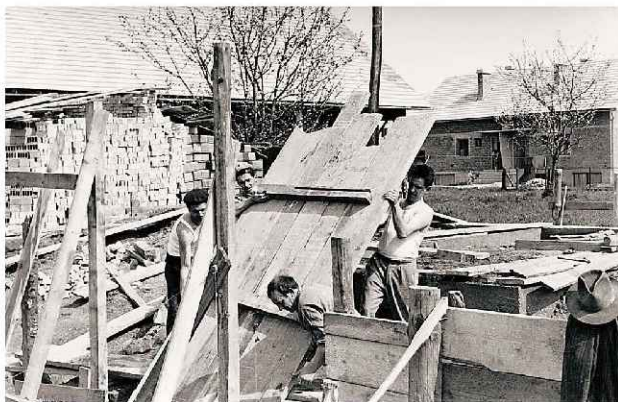
Sredi 60. let so domačini s prostovoljnim delom zgradili novo trgovino z mesnico in prostore krajevne skupnosti. Na sliki so Drago Hafner, Ivan Avguštin, Franc Krafnik in Peter Bobnar pri postavljanju opaža za betoniranje. (foto: Jože Rant)
