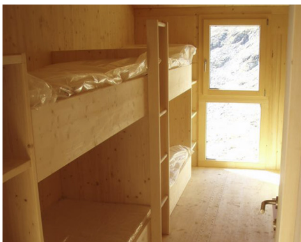
Slika 9. Notranjost lesene gorske kočice, izdelane iz CLT lesa (Kreuzinger, 2010).
