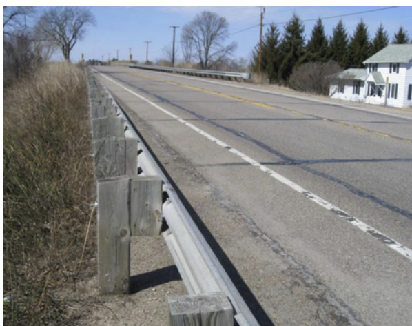
Slika 7. Leseni stebri zaščitne ograje (Wacker in sod., 2010).
