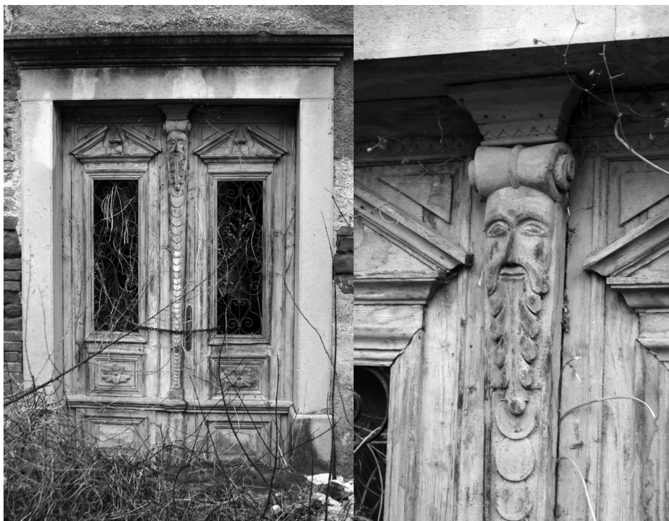
Vrata pred obnovo
