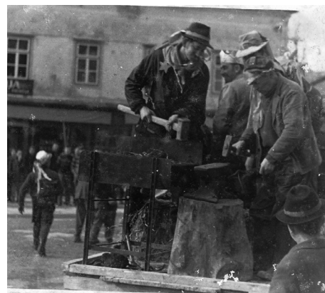
Del zemonskega pustnega sprevoda na Placu
