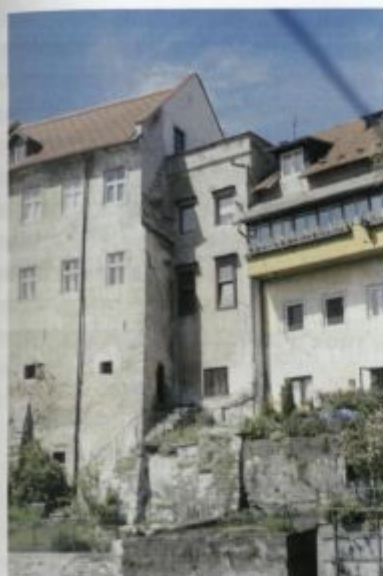
Zazidan prehod med Kajbetovo in Zofkeževo hišo. (Foto: France Štukl)
