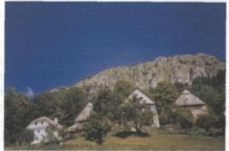
Obnovljene hiše v Zabrdu
