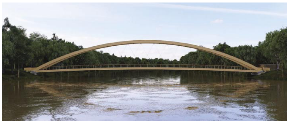
Slika 1 • Pogled na brv
