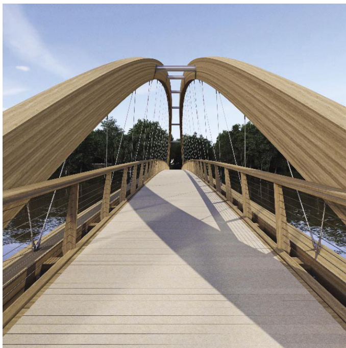
Slika 6 • Navznoter nagnjena loka povečujeta stabilnost konstrukcije
