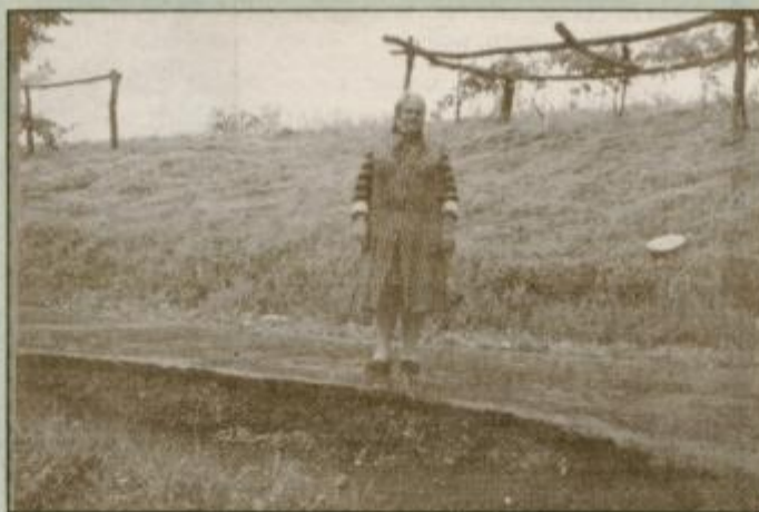
Pred hišo Julijane Reihss je v asfaltu zazijala razpoka
