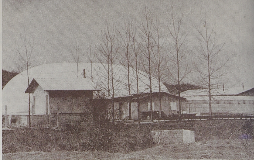
Atomske toplice danes. Lani so jih preuredili, zgradili nov bazen in ga prekrili s posebnim šotorom. Po dolgih letih so začeli načrti le postajati resničnost.
