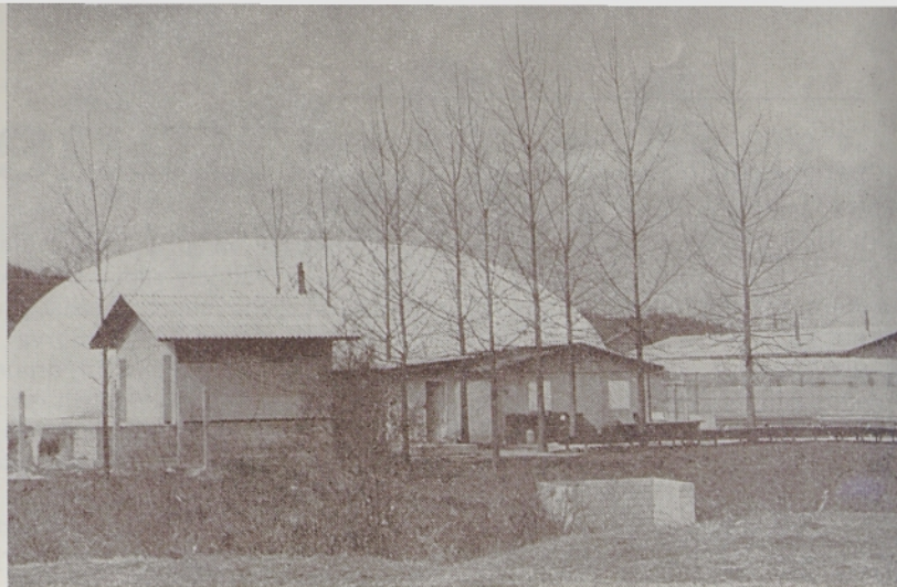
Atomske toplice danes. Lani so jih preuredili, zgradili nov bazen in ga prekrili s posebnim šotorom. Po dolгих letih so začeli načrti le postajati resničnost.
