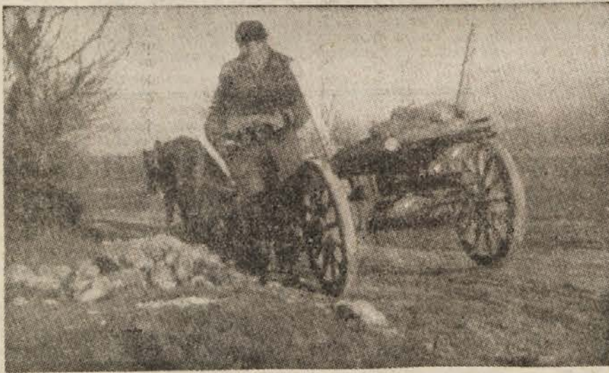
S kamenjem, ki so ga izkopali, bodo posuli cesto.
