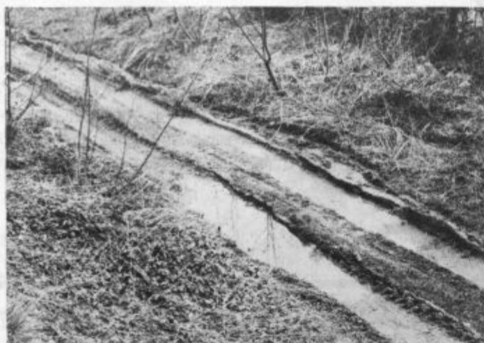
Narava je neusmiljena in neredno vzdrževanje "sproti" kaznuje
