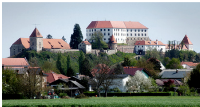
Grajski kompleks, spomenik državnega pomena, ki je v državni lasti, zahteva redno vzdrževanje in številne investicije.
