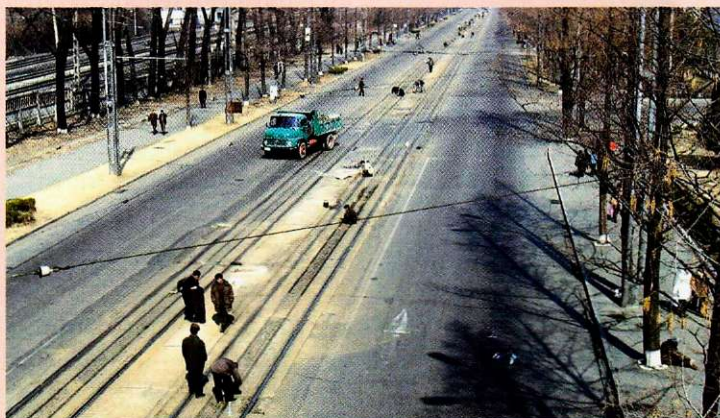
Ljudje pod nadzorom popravljajo tračnice.
