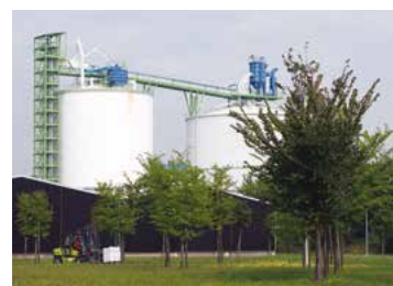
Silosa za glinico
