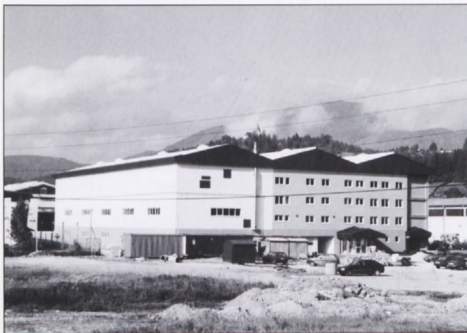
Lamitex v Slovenj Gradcu - pod streho
