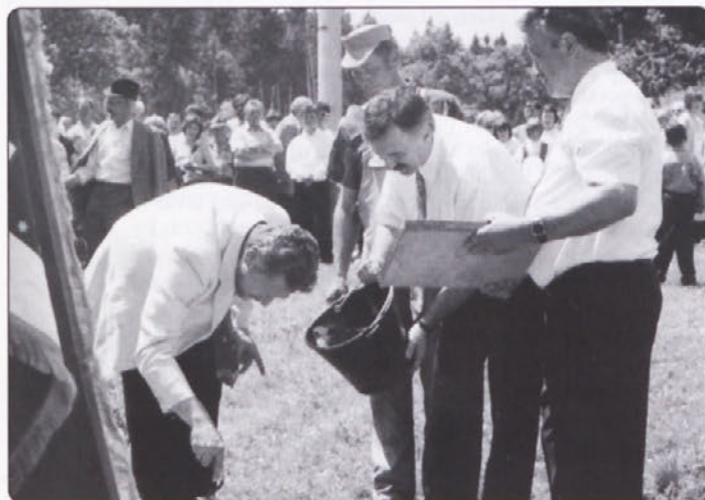
Šolarji na Kapli so letos predčasno končali s poukom. Mudilo se je namreč s položitvijo temeljnega kamna in s tem začetkom gradnje nove šole, ki jo Kapelčani že tako dolgo željno čakajo. Zdaj gre zares. Posnetek Franc Jurač
