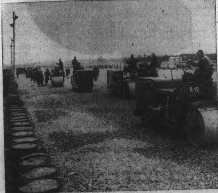
Grade novo letališče. — Slika nam kaže parne valjarje pri delu 6.000 črtjev dolge-ga letališča, ki se že bliža izgotovitvi v francoskem sektorju Berlina, kjer je vsled ruske blokade jako pomnožen zračni promet. Vse gradbene stroje so pripeljali v Berlin z velikimi transportnimi letali.
