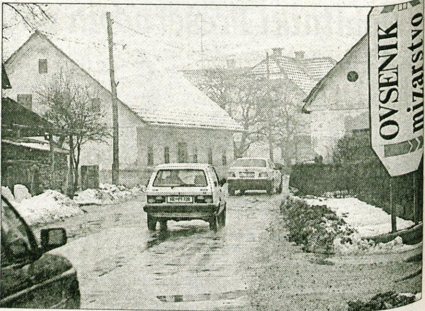
Jezerska cesta čaka na obnovo.
