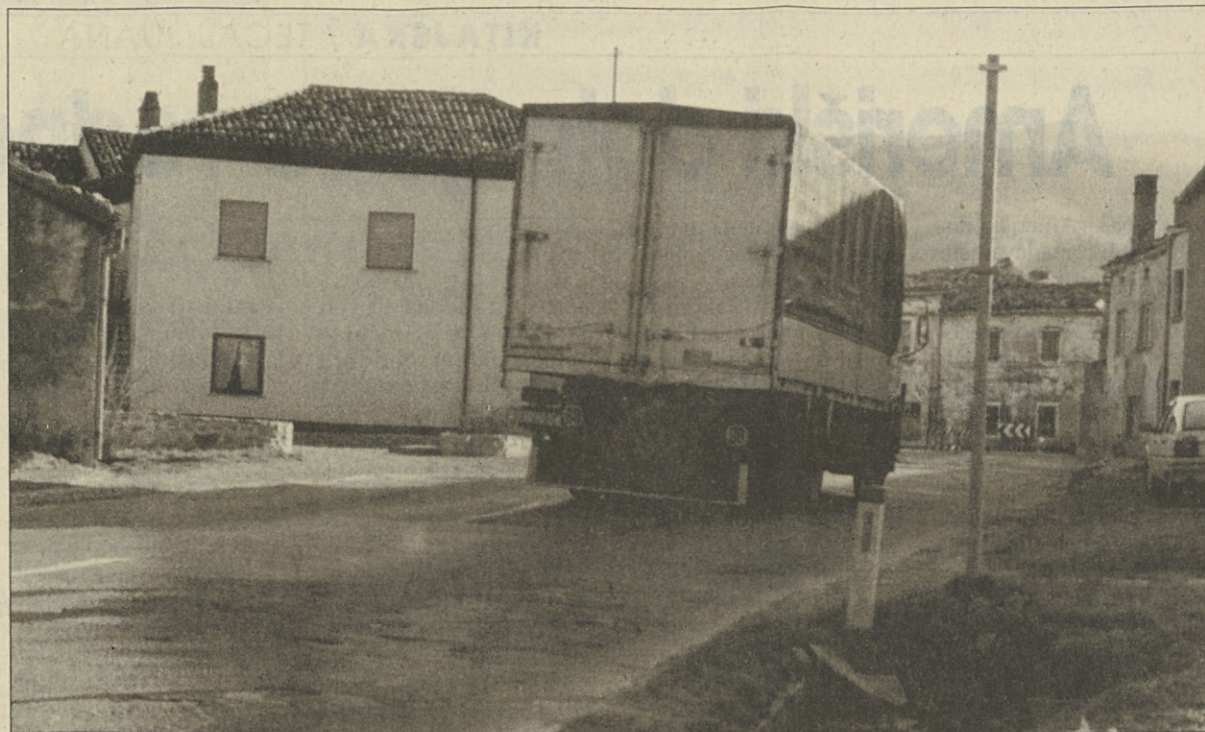
Cesta skozi Podnanos: asfalt se dobesedno drobi pod kolesi tovornjakov. (Foto: A. Lipovž)
