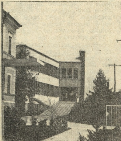
Novi oddelek Splošne bolnišnice v Brežicah — gradil »GRADBENIK«
