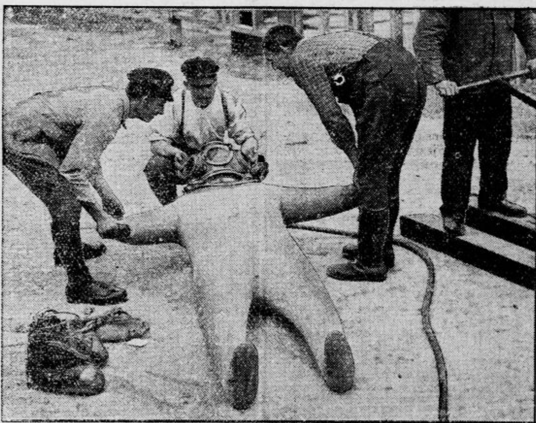
Preizkušnja potapljaške opreme, če ne propušta vode
